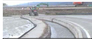
止まらない水路の三面張り
