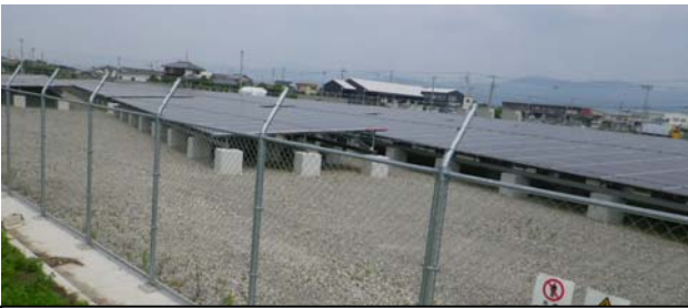
↑ 雑木林を伐採して建設されたソーラー発電施設
