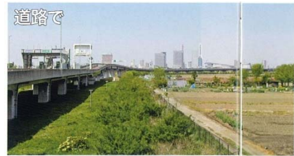
道路で 道路の建設時に、幅約40m、長さ1.7kmにわたり高架下をビオトープとすることを決定。近隣の小中学校などと連携し、自然再生が進められています。幼稚園児の自然体験や大学・専門学校学生の学生の実習にも利用されています 首都高 埼玉新都心線(埼玉県)
